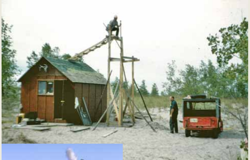
Construit un puits d'eau en 1960.
